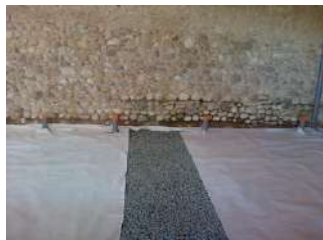
ÉTAPES DE RÉALISATION CARRELAGE TOMETTES TERRE CUITE SUR CHAPE SÈCHE CHAUX-SABLE
