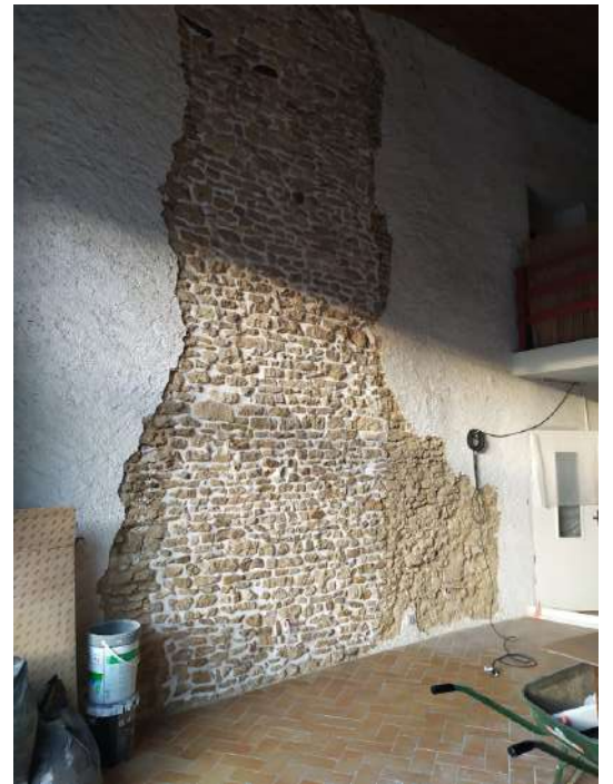
REALISATION ENDUIT CHAUX PIERRES APPARENTES
