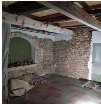
DECROUTAGE ENDUIT CIMENT
