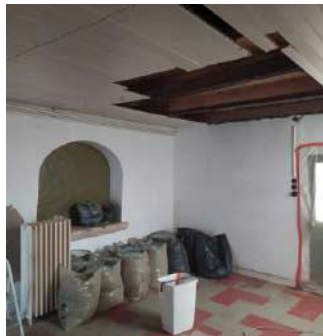
DÉPOSE FAUX PLAFOND
