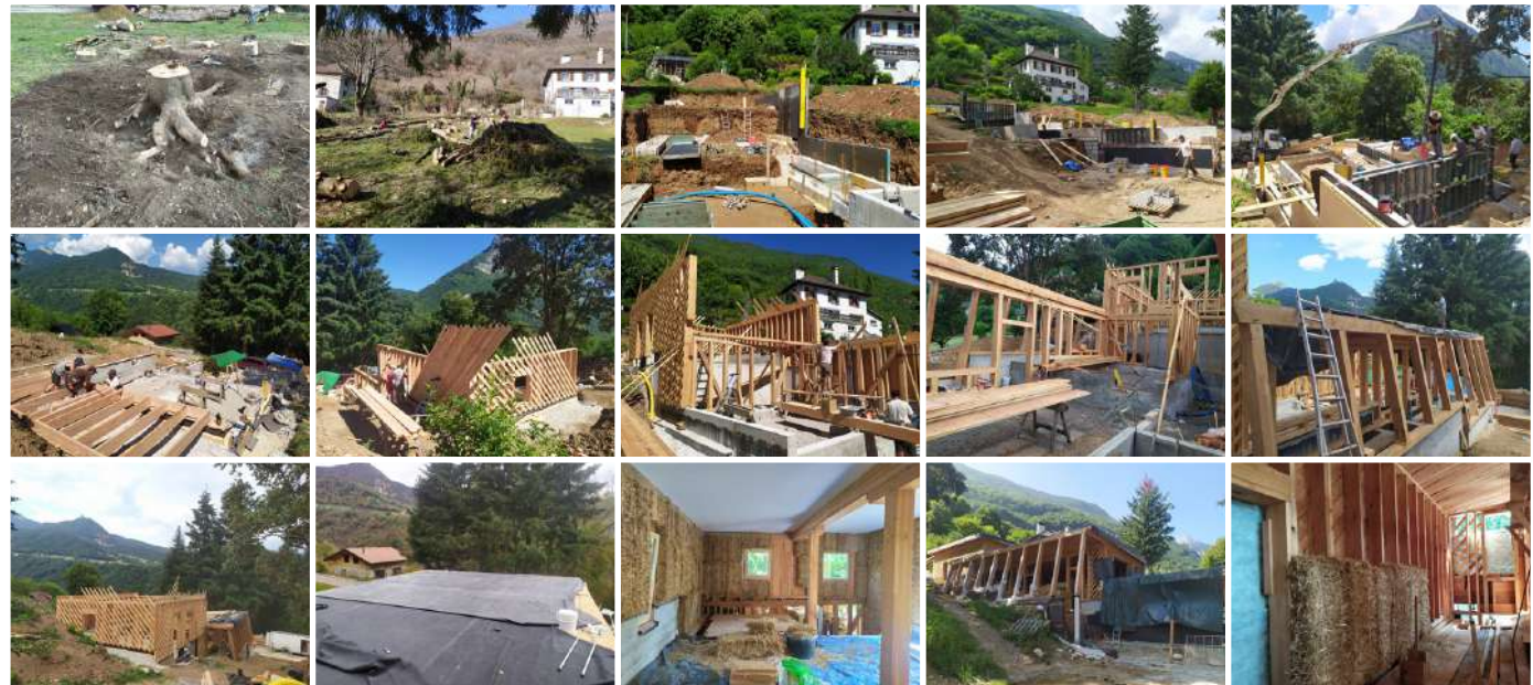
PHOTOS DE L'AVANCEMENT (DÉSOUCHAGE, TERRASSEMENT, FONDATIONS, OSSATURE BOIS, ÉTANCHÉITÉ EPDM, PAILLE)
