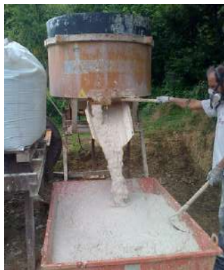
ÉTAPES DE RÉALISATION CARRELAGE TOMETTES TERRE CUITE SUR CHAPE SÈCHE CHAUX-SABLE
