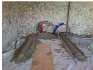
ÉTAPES DE RÉALISATION CARRELAGE TOMETTES TERRE CUITE SUR CHAPE SÈCHE CHAUX-SABLE
