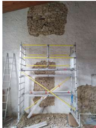
DECROUTAGE ENDUIT CHAUX
